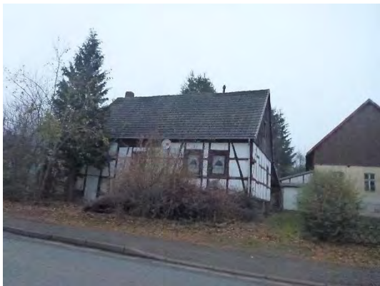
Bild 36: Leerstehendes Wohngebäude in der Ortslage
