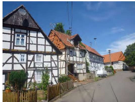
Bild 63: Ansicht zu einem leerstehenden Gebäude in Schmillinghausen (kleineres Gebäude in der Mitte des Bildes)
