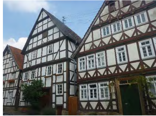
Bild 41: Wohngebäude in der Langen Straße
