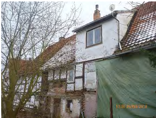
Bild 62: Ansicht zu einem leerstehenden Gebäude in Schmillinghausen
