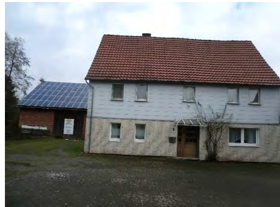
Bild 39: Leerstehendes Wohngebäude in der Thielestraße
