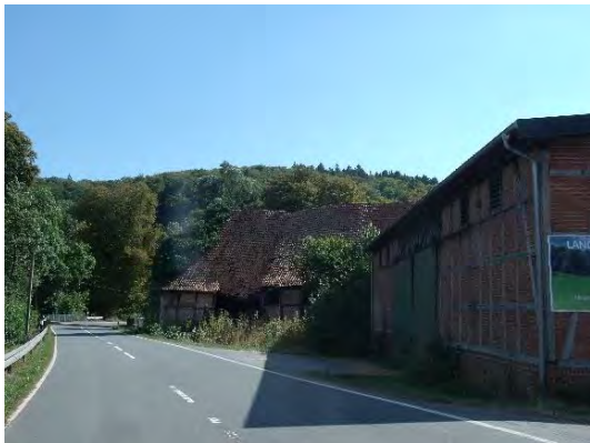
Bild 26: Nebengebäude des Gutshofes Eilhausen, im Hintergrund befindet sich ein stark einsturzgefährdetes Gebäude
