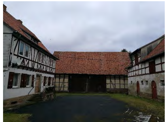
Bild 8: Dreiseitige Hofanlage in Neu-Berich
