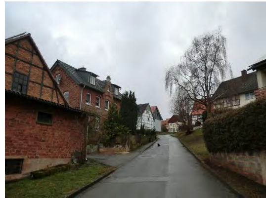
Bild 33: Blick in die Thielestraße aus südlicher Richtung
