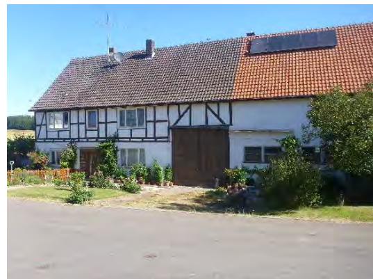
Bild 65: Gebäude in der Elleringhäuser Straße 4
