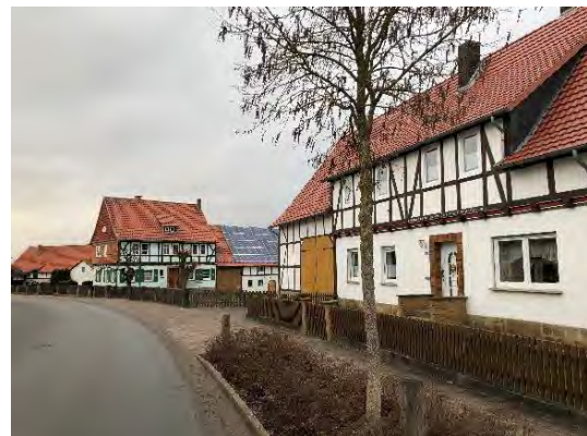
Bild 53: Blick in die Bericher Straße aus Richtung Lindenfeldstraße
